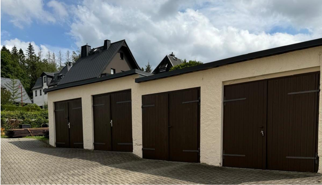
Garagen im Innenhof
